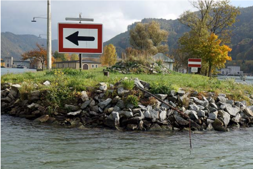
Abbildung 4: Der „neue“ Logger Nr. 0 hängt an der an einer Stange montierten Kette am Trenndamm KW Jochenstein.
